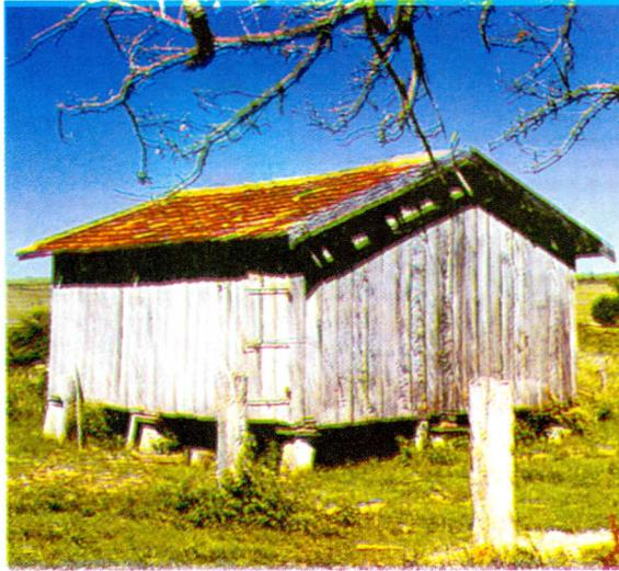
Figura 7. Galpão tradicional de madeira, para armazenamento de grãos, geralmente milho em espigas, com estrutura de construção inadequada para um bom funcionamento.
