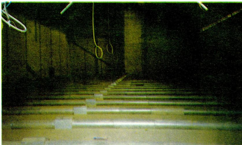
Figura 5. Interior de um armazém graneleiro, com ductos de aeração e cabos de termometria, para manejo de controle de qualidade dos grãos durante o armazenamento.
