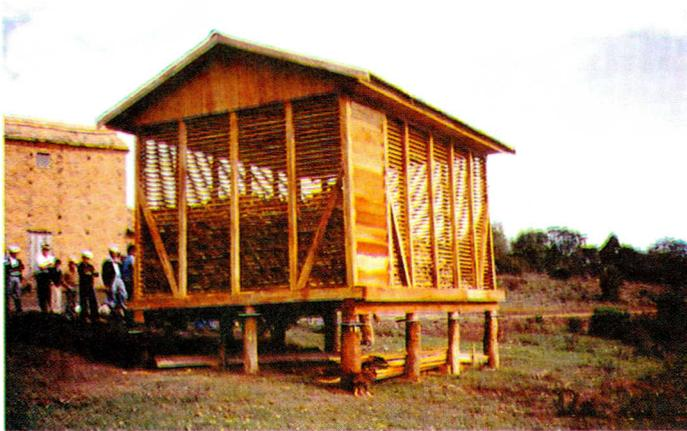
Figura 8. Paiol ripado para armazenamento de grãos em espigas, na palha, com ventilação por convecção natural e dispositivo anti-rato na forma de saia de lata ou chapéu chinês
